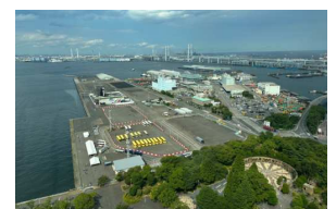
山下ふ頭全景
